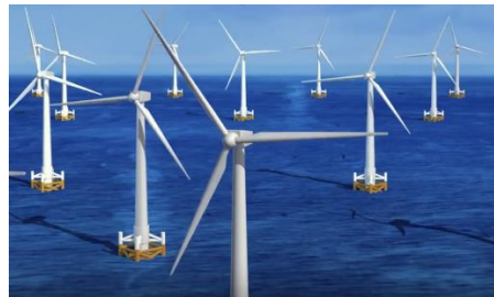
水平軸發電機
